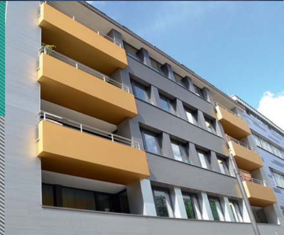
Verkleidung mit Paneel AP100T, beschichtet DB703 Victorstr. Koblenz
