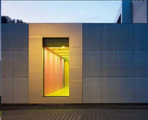
Verkleidung mit Paneel AP100T, beschichtet DB703 Victorstr. Koblenz
