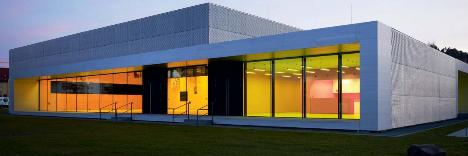
Paneelverkleidung AP100F eloxiert in Kombi- nation mit Streckmetall Sport und Kulturhalle, Pegnitz
